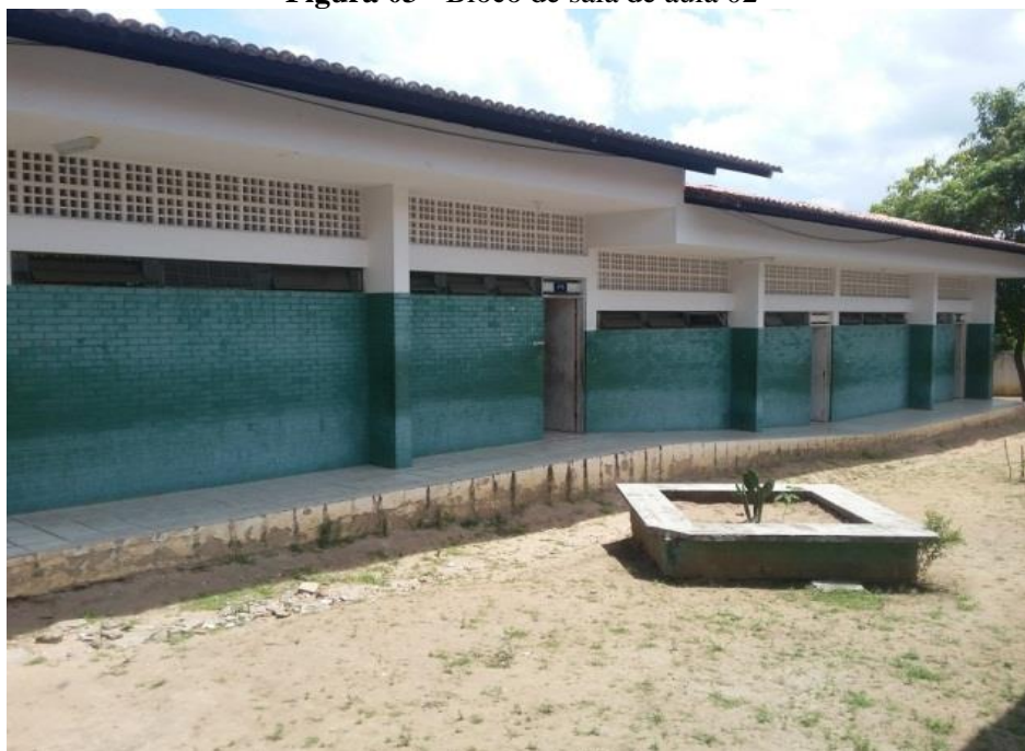
Figura 03 - Bloco de sala de aula 02
