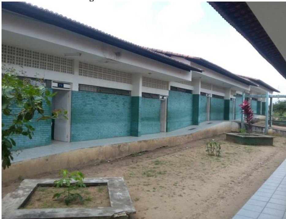
Figura 2 - Bloco de sala de aula 01
