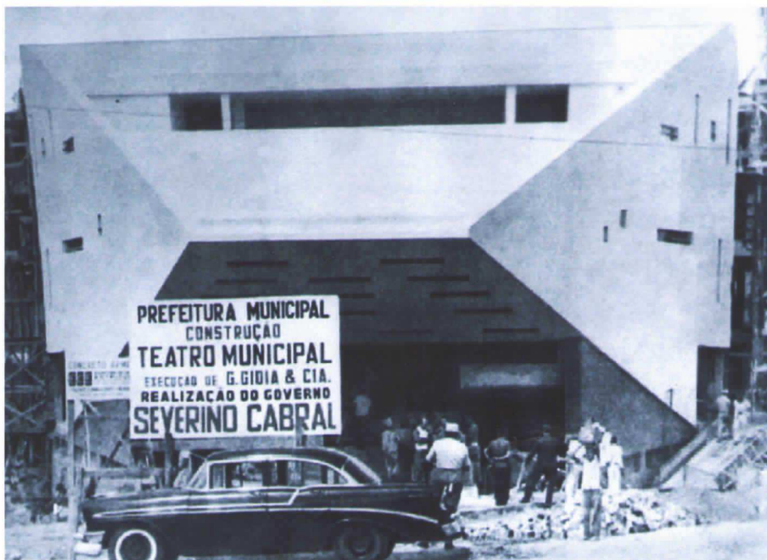
O Teatro Municipal Severino Cabral em fase final de construção, podemos notar nesta foto as rampas laterais que na reforma de 1975 serão retiradas.
