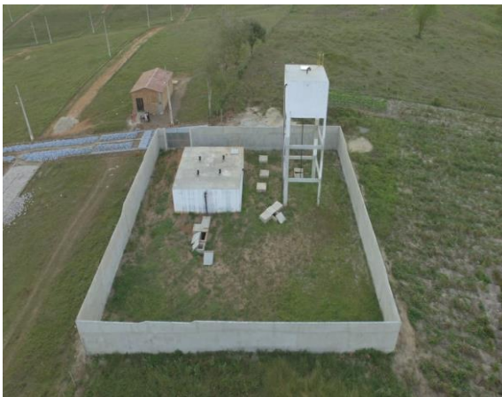
Imagem 17: Caixa d'água do loteamento Bela vista
