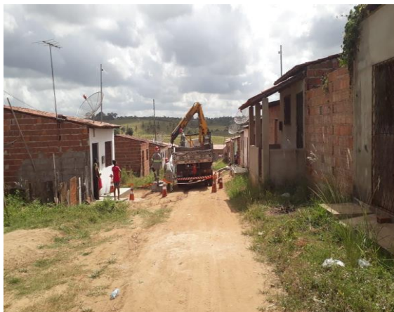
Imagem 29: Instalação de postes no conjunto Habitacional em Araçagi
