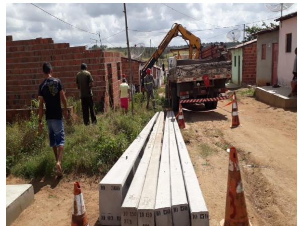
Imagem 30: População acompanha instalação de postes no Conjunto Habitacional em Araçagi
