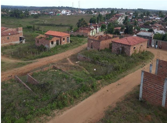
Imagem 25: Ruas sem calçamentos no loteamento doado pela PMA
