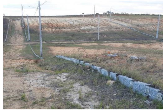
Imagem 22: Loteamento Alto da Serra
