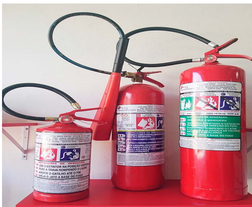
Figura 6: Extintores de incêndio PQS, CO 2 e água pressurizada.
