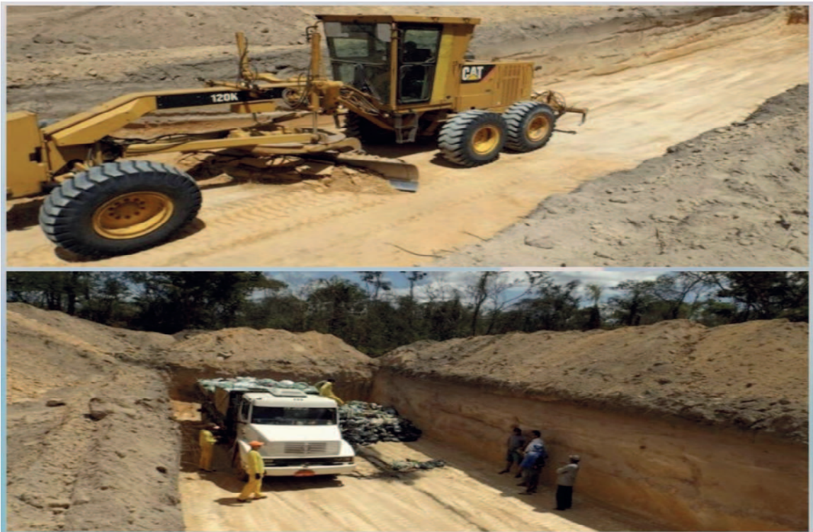
Figura 4- Vala de aterro controlado
