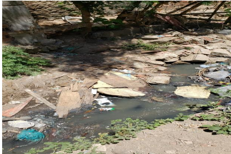
Figura 7: Trecho de parte do canal – Pedregal II
