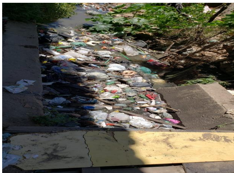
Figura 8: Trecho de parte do canal – Pedregal III
