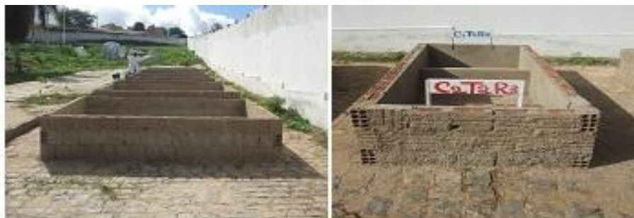
Figura 11- Fotos do Sistema de Tratamento Descentralizado de Resíduos Sólidos Orgânicos Domiciliares – SITRADERO sem a cobertura. Santa Rosa, Campina Grande-PB, março de 2011.
