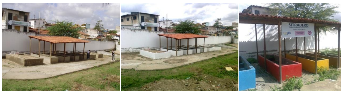
Figura 12- Fotos do Sistema de Tratamento Descentralizado de Resíduos Sólidos Orgânicos Domiciliares – SITRADERO com a cobertura e pintura. Santa Rosa, Campina Grande-PB, Agosto de 2012.
