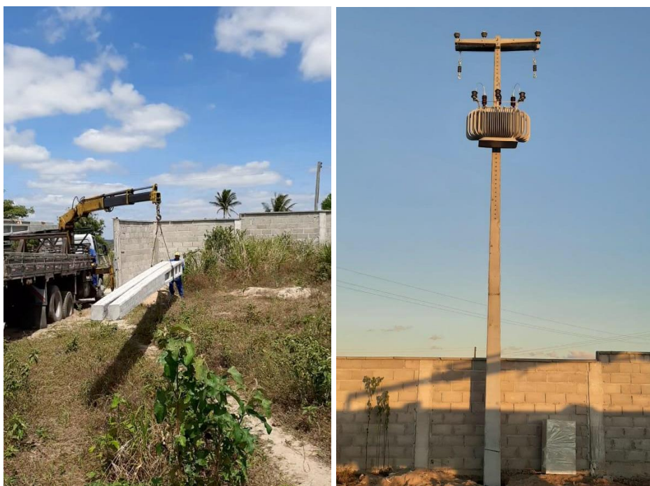
Figura 17 – Instalação dos postes posicionados nas valas
