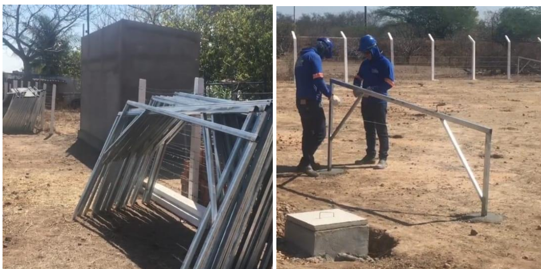
Figura 20 - Instalação dos perfis de aço galvanizado
