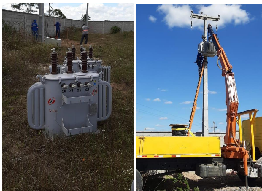
Figura 18 – Montagem e fixação do transformador ao poste
