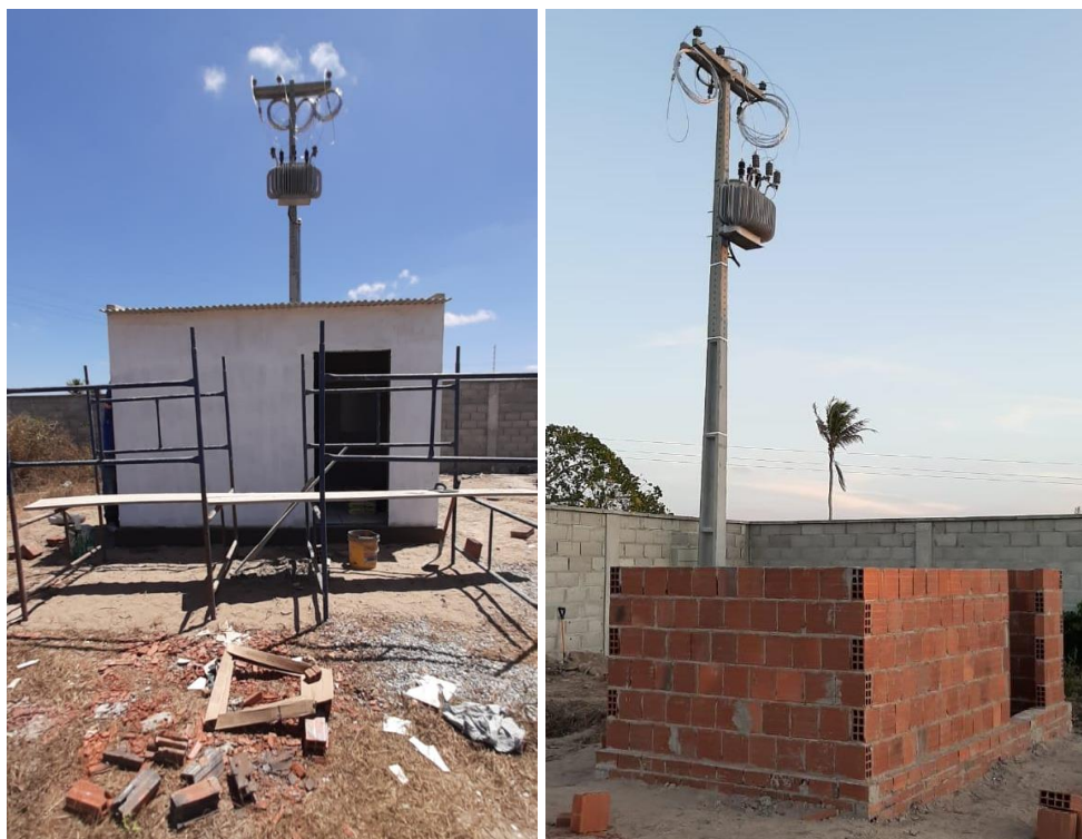
Figura 19- Execução dos abrigos dos inversores
