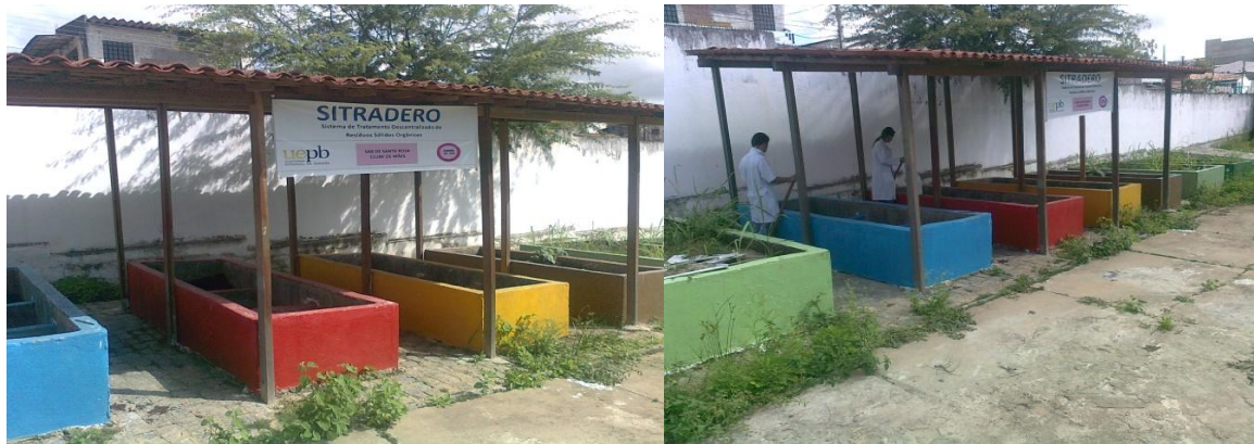
Figura 3: Fotos do Sistema de Tratamento Descentralizado de Resíduos Sólidos Orgânicos Domiciliares com cobertura instalado no Bairro de Santa Rosa. Campina Grande-PB, março de 2012.
