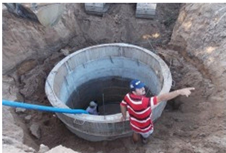
Figura 22 - Perfuração de poços em São João do Rio do Peixe-PB
