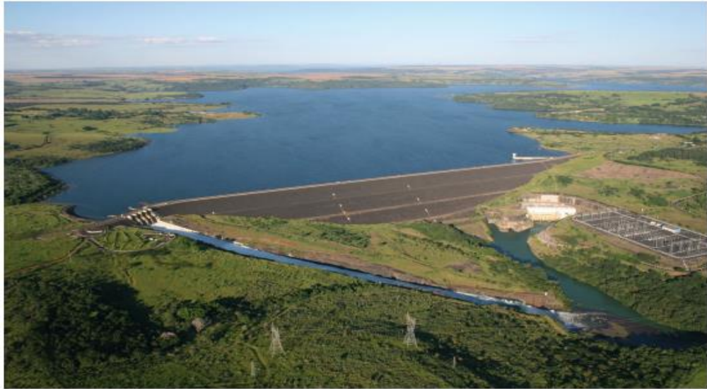
Figura 4 - Barragem não galgável
