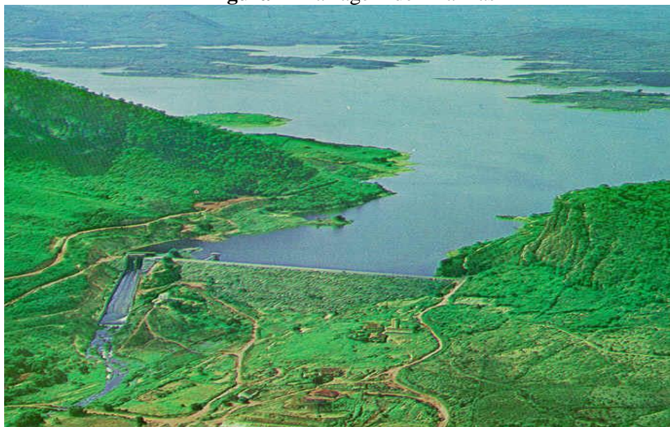
Figura 1- Barragem de Piranhas
