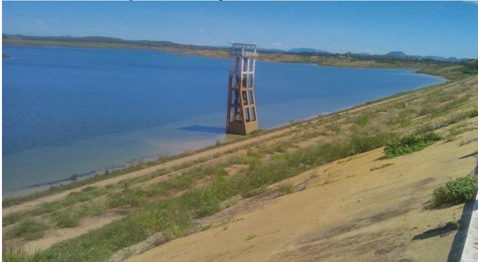
Figura 2 - Barragem de Coremas
