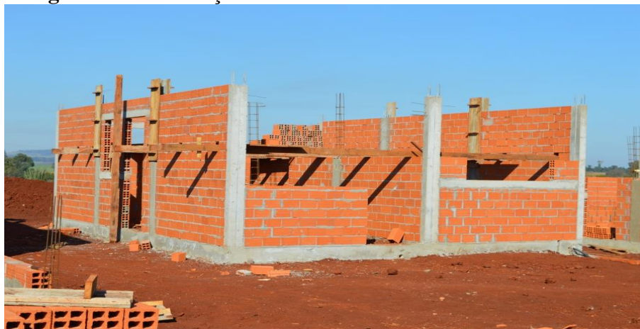
Figura 24 - Construção das novas casas da comunidade Lancha I
