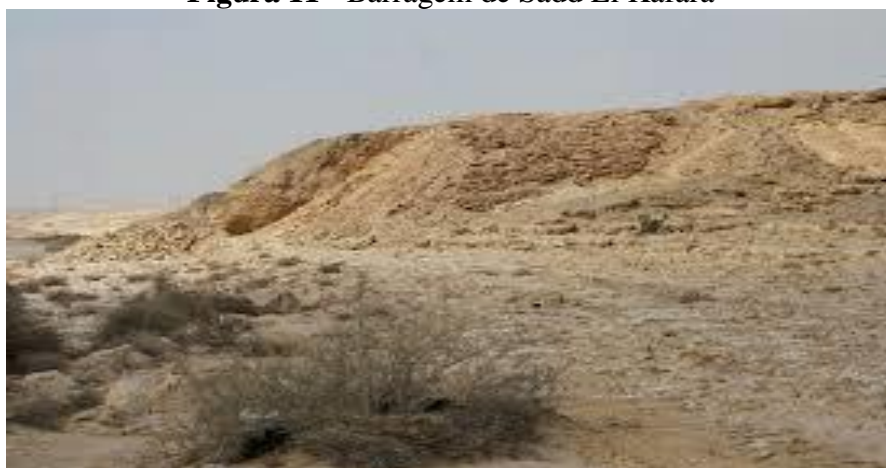
Figura 11 - Barragem de Sadd El Kafara
