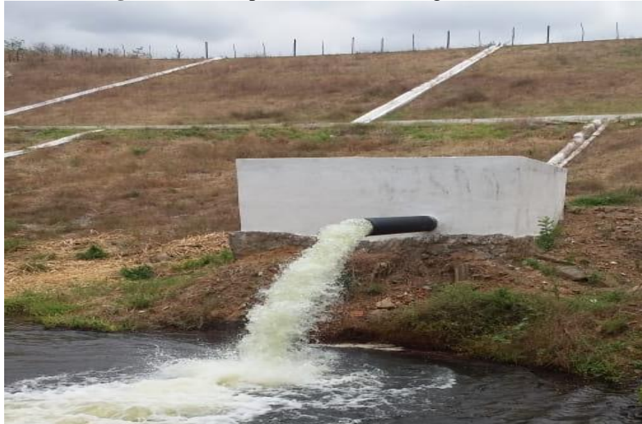
Figura 21 - Comporta aberta da barragem Lancha I
