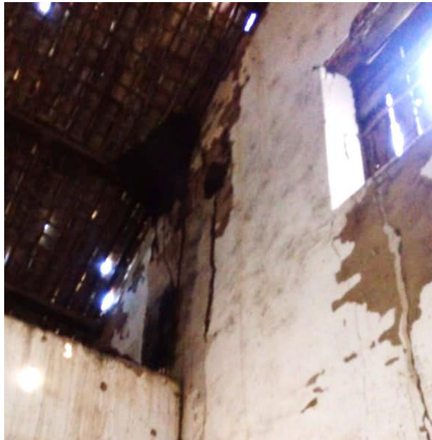
Figura 26: Presença de cupins nas estruturas de madeira 2
