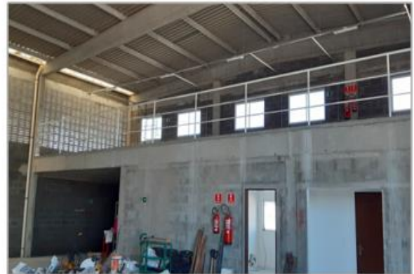
Figura 10 - Visão interna do novo galpão de Triagem da Coleta Seletiva - ASTREC
