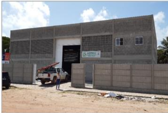
Figura 9 - Visão externa do novo galpão da Unidade de Triagem de Recicláveis - ASTREC
