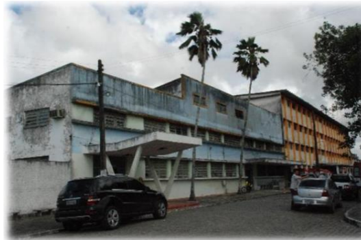
Figura 4: Fachada do antigo Hospital João Ribeiro, 2005.
