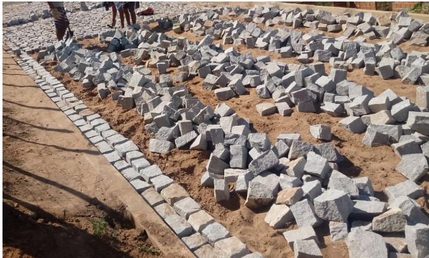
Figura 03 – Rochas cúbicas utilizada em pavimentos de paralelepípedo
