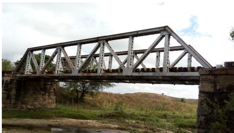
Figura 7 – Ponte Ferroviária sobre o Rio Bacamarte.
