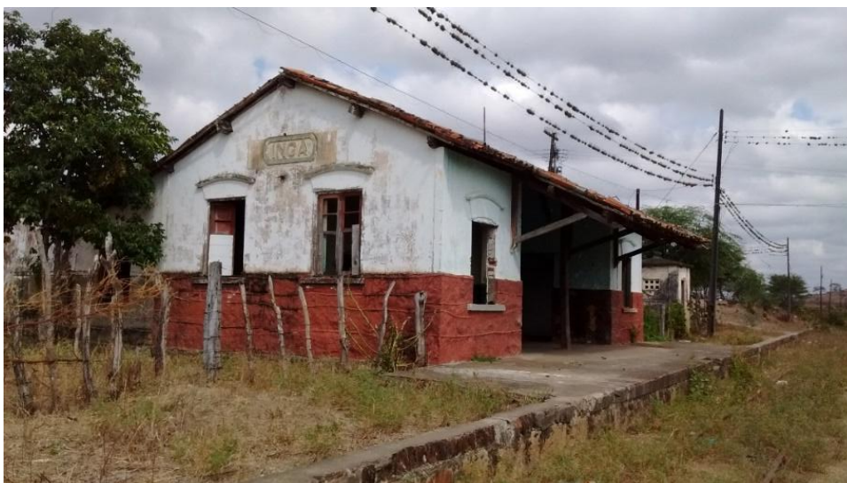
Figura 8 – Antiga Estação Ferroviária de Ingá- PB em abandono
