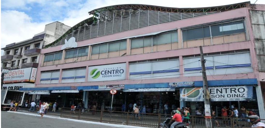
Figura 5 - Shopping Centro Edson Diniz, localizado na Rua Marquês do Herval, 38, Centro.
