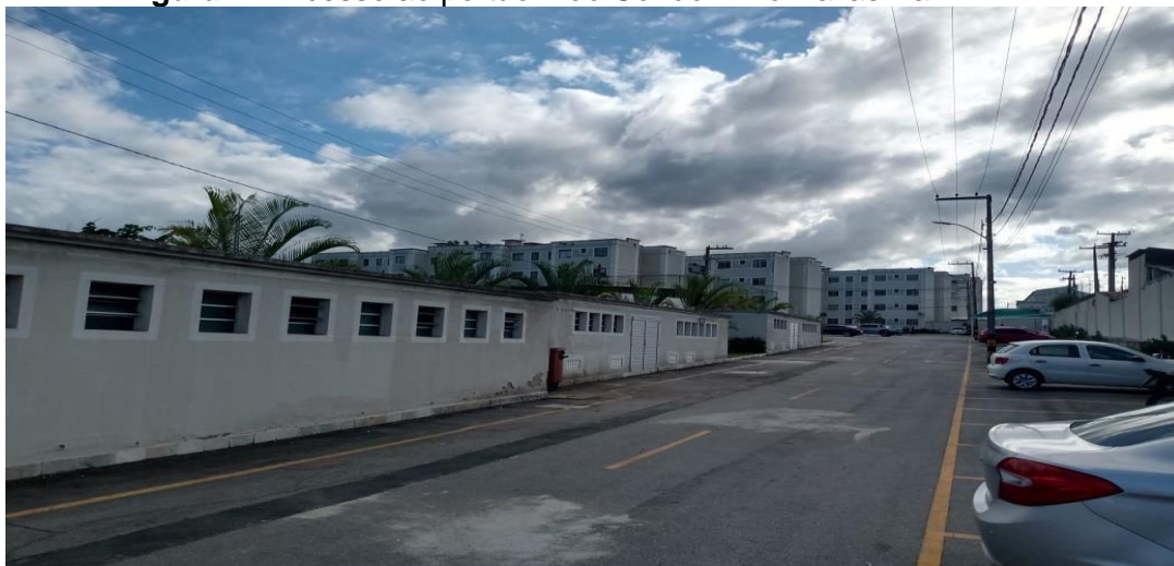
Figura 4 – Acesso ao portão 1 do Condomínio Dallas Park
