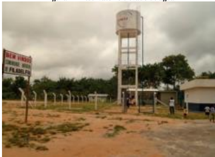
Figura 7 - Reservatório elevado de água
