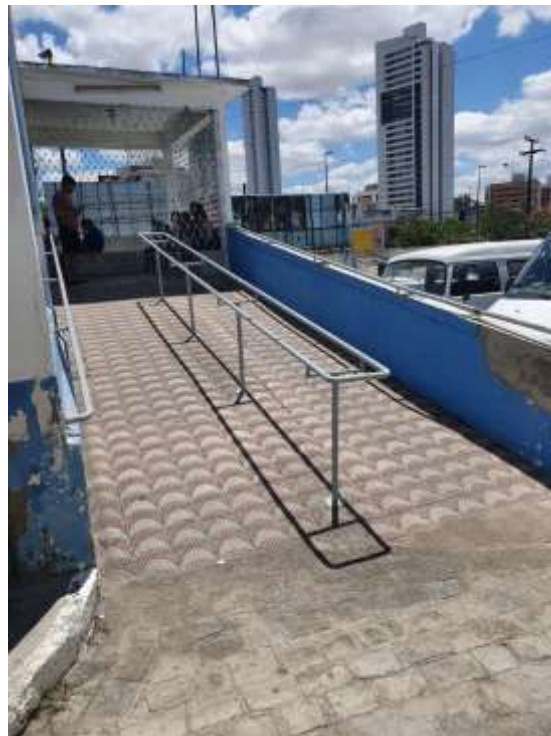
Figura 4: Corrimão utilizado pelos deficientes visuais diariamente para o acesso ao instituto.
