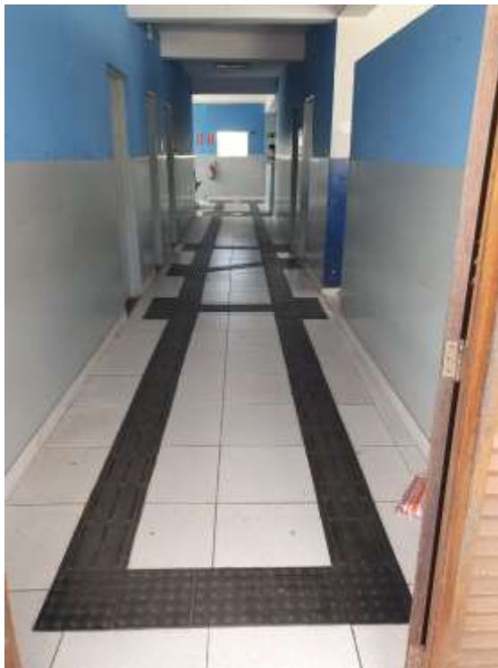
Figura 5: Corredor adaptado que dá acesso as salas de aulas, biblioteca, dormitório, banheiro, sala de informática.
