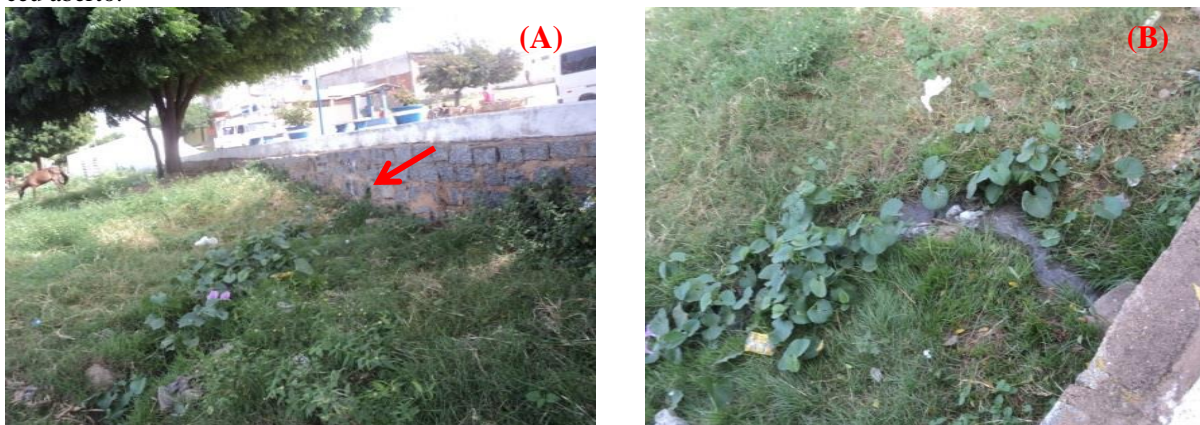
Figura 12 – Lançamento de esgotos in natura nas águas do reservatório: (A) ponto de lançamento e (B) esgoto a céu aberto.
