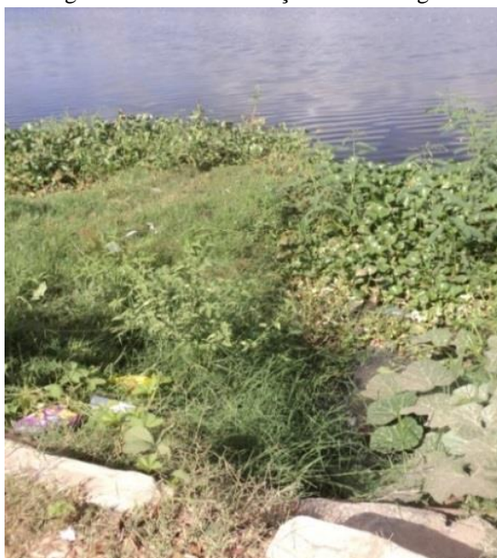
Figura 15 - Ponto de lançamento de esgoto.
