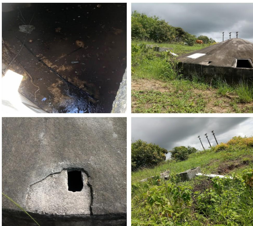
Figura 12 - Cisterna Danificada
