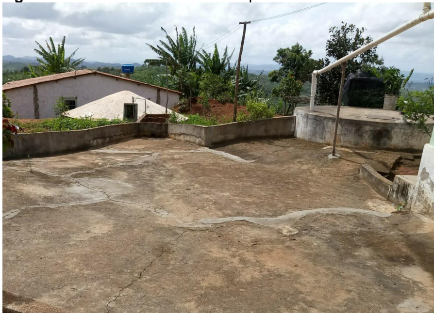
Figura 13 - Cisterna Enxurrada Adaptada
