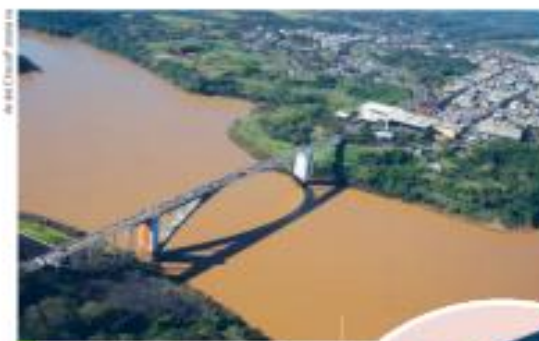
Figura 7. Ponte da Amizade, entre Foz do Iguaçu (PR), na parte superior da imagem, e Ciudad del Este (Paraguai), na parte inferior da imagem, 2015.
