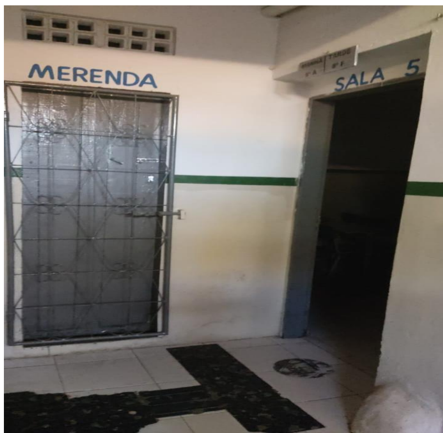
Figura 5- Área de armazenamento da merenda escolar
