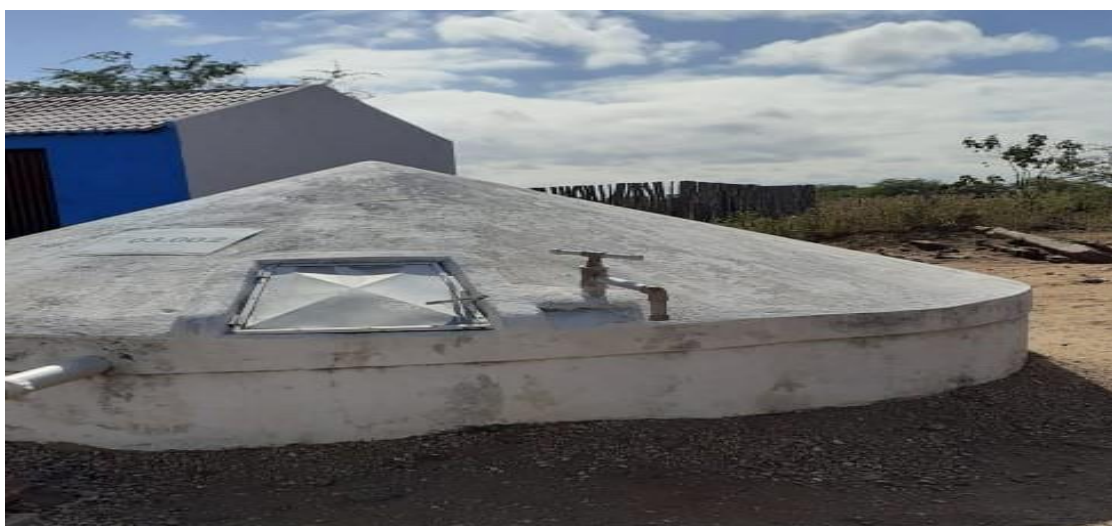
Figura 07: Cisternas de placas na comunidade Olho D'Água da Cidade de Livramento/PB
