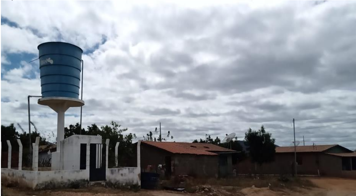
Figura 11 - Caixa de distribuição de água em povoados rurais de São José da Lagoa Tapada/PB
