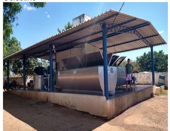
Figura 24 – Laticínio localizado no bairro Celestino
