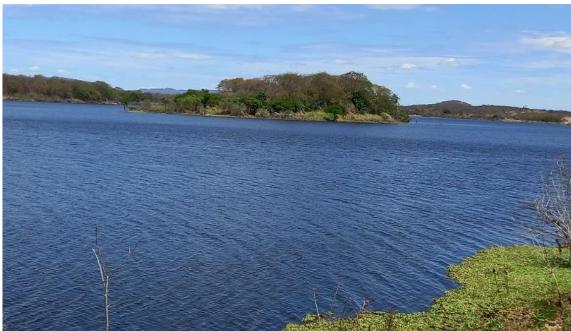
Figura 3 – Vista do Açude do perímetro irrigado de São Gonçalo, Sousa/PB
