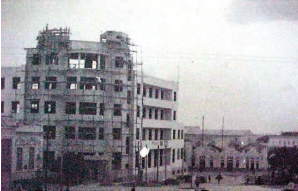
Imagem N° 5: Construção do Grande Hotel na década de 1940
