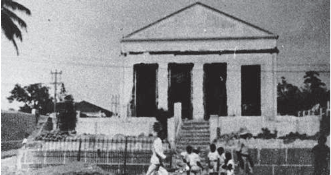
Imagem N° 3: Casa de Demóstenes Barbosa sendo demolida
