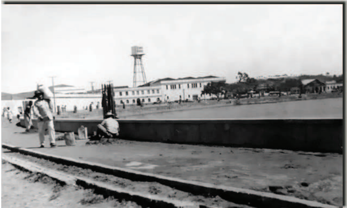
Imagem Nº 13: Açude velho durante a construção do cais circular, ano de 1942
