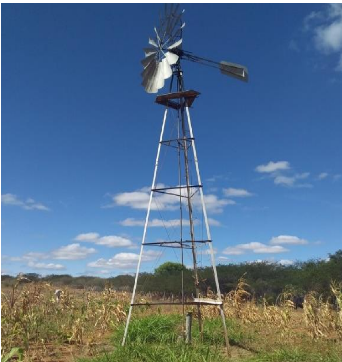
Figura 13 - Poço com cata-vento da comunidade do Sítio Farias. Fonte: A autora (julho/2021).
