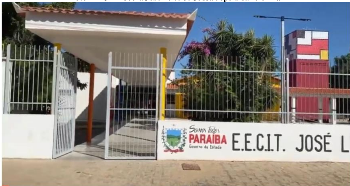
Foto 4 ECTI Escola José Leite de Sousa depois da reforma
