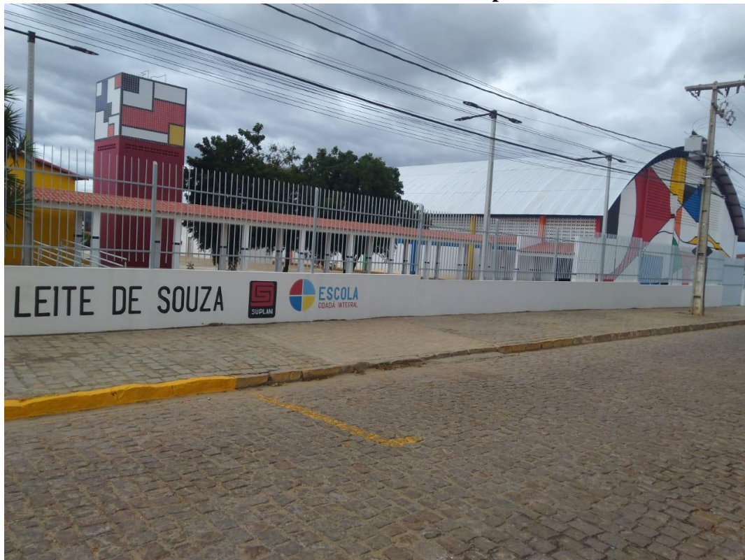
Foto 5 ECTI Escola José Leite de Sousa depois da reforma
