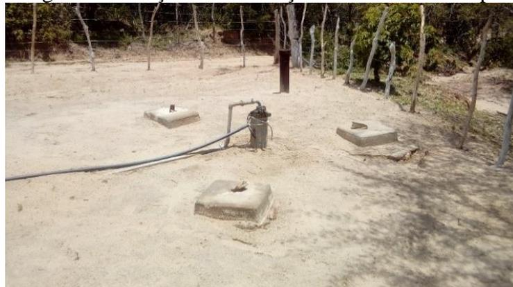
O manejo do efluente concentrado no sistema Massapê ocorre por disposição no solo, contando com uma caixa água de passagem, conforme ilustrado nas Figura 14 e 15.
