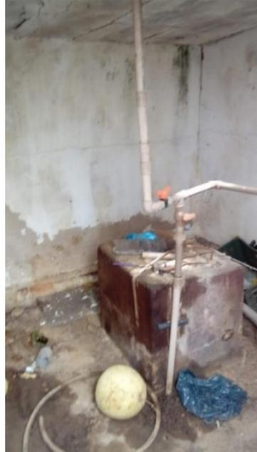
O efluente concentrado do sistema Mendonça é disposto em tanque de contenção para evaporação, conforme é possível verificar na Figura 18.
