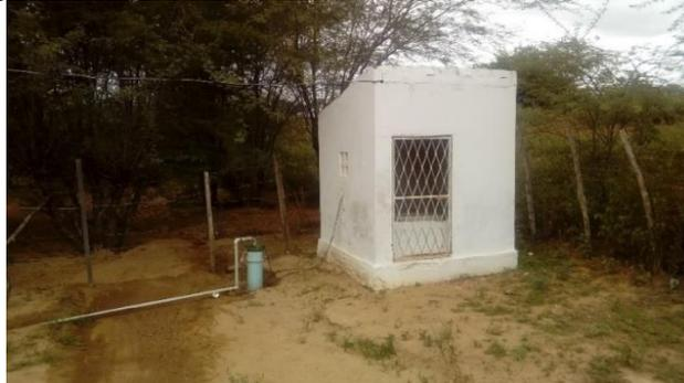
O manejo do efluente concentrado é feito lançando-o diretamente do dessalinizador para o solo, conforme é possível observar na Figura 11.
