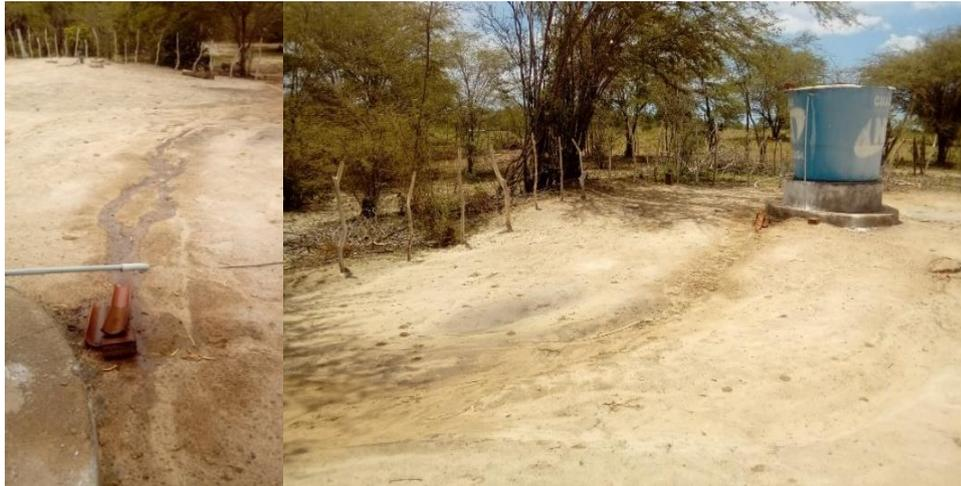
Figura 15 - Caixa d'água utilizada para armazenar o efluente concentrado do sistema Massapê
