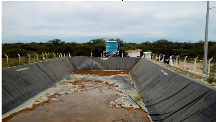
As dimensões da instalação do sistema Mendonça são as dimensões padronizadas pelo PAD, que para o tanque de contenção estabelece profundidade de 2 m, largura de 8 m e comprimento de 26 m, no fundo do talude, e inclinação de 0,075 m.
