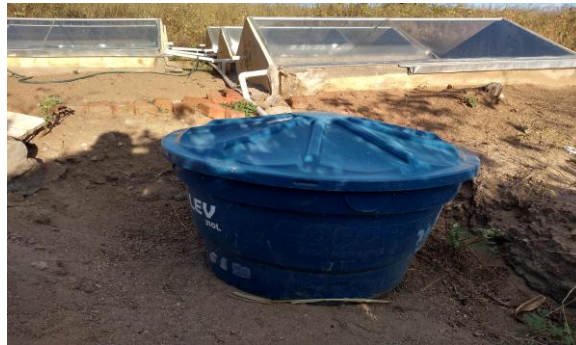
Figura 4. Caixa de PVC usada para armazenar a água isenta de sais.
