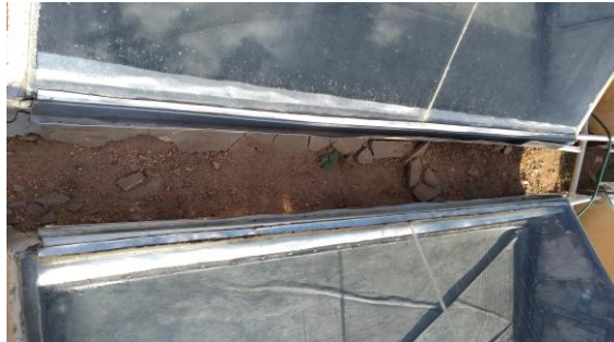
Figura 2. Calhas laterais no interior e por fora.
