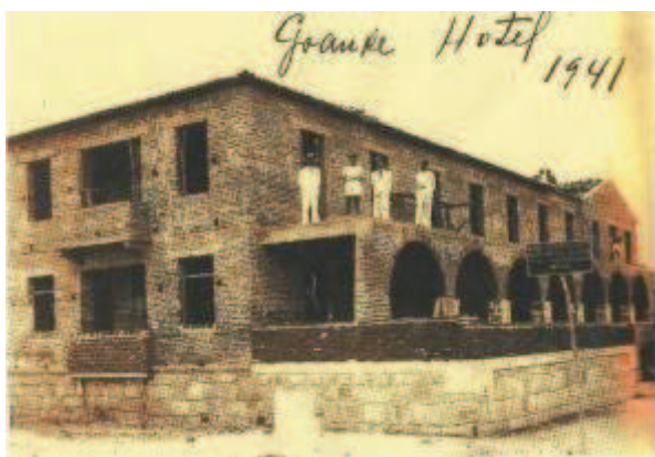
Imagem 21: vista lateral da construção do Grande Hotel em 1941. Fonte: arquivo do Museu Histórico de Monteiro.
