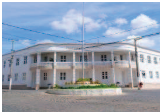
Imagem 8: Edifício-sede da Prefeitura Municipal. Estilo característico de meados do século XX, com uma denotação de modernidade, com linhas mais racionais e o uso do concreto armada. Fonte: arquivo pessoal da pesquisadora.
