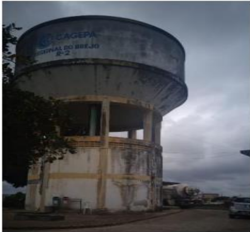
Figura 16c: Vista do reservatório R2 elevado (R2E)
