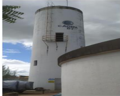
Figura 16b: Vista do reservatório R1 elevado (R1E)
