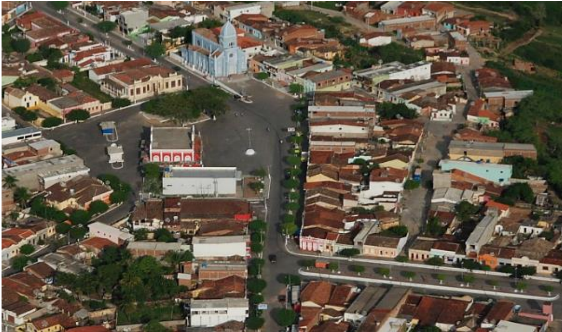
Figura 08: Vista aérea do centro Histórico da cidade de Umbuzeiro-PB.
