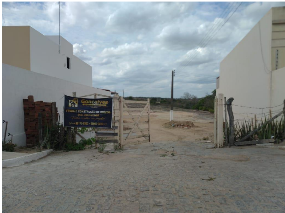
Figura 10: Construção no entorno do espaço urbano-rural da cidade de Puxinanã-PB.
