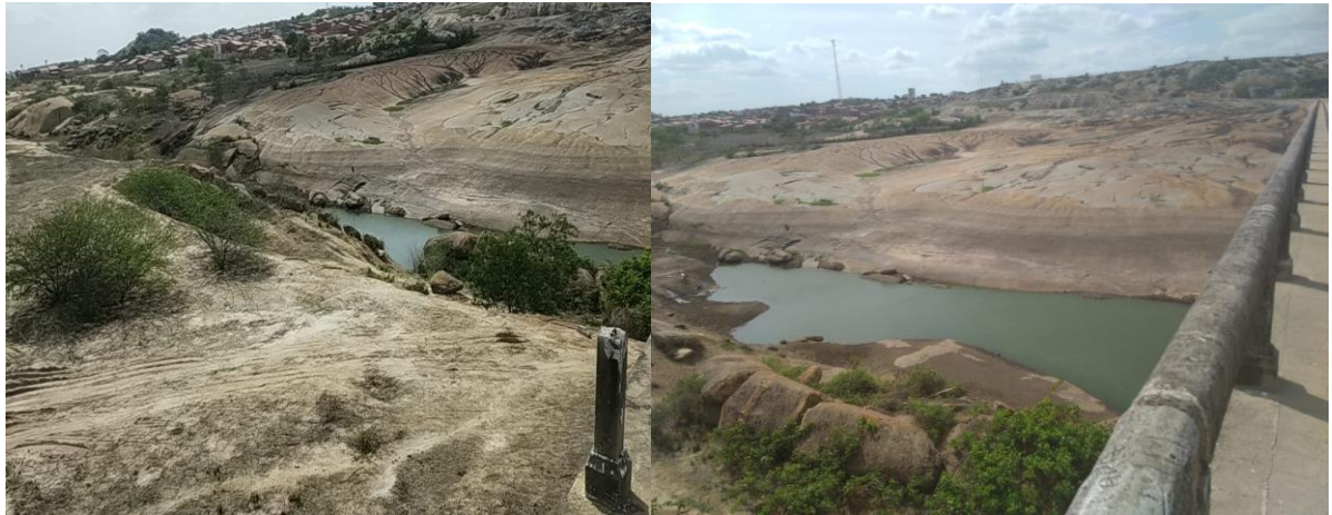
Figura 04: Açude João Suassuna – construído em 1924.
