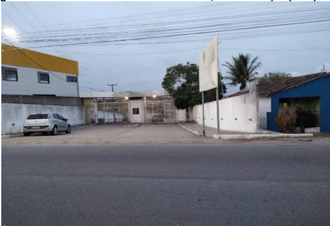
Figura 11: Entrada do Condomínio Real Madrid, em construção (2013).
