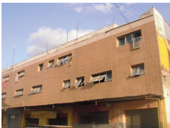
Imagem 8: Atual parte lateral do prédio. *fotografadas pela pesquisadora.
