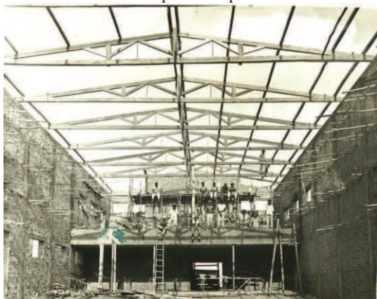
Imagem 6: Interior da construção .
