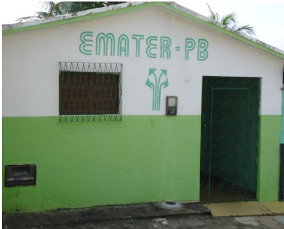
Foto 10 – Prédio da Emater – PB, locado pela Prefeitura Municipal. Fonte: Autor, 2013.
