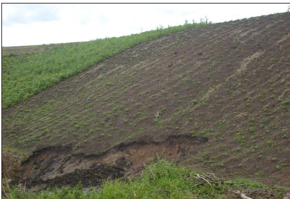
Figura 6: Deslizamento de encosta ocupada por culturas de subsistência, sítio Curral Grande, Itapororoca/PB. Fonte: SILVA, 2009
