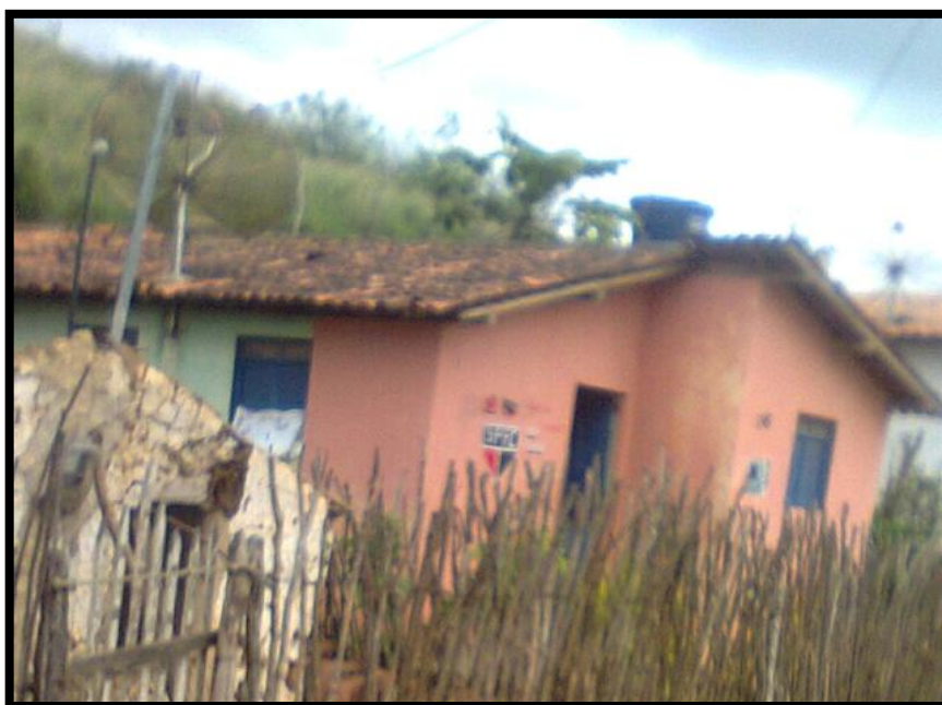
Figura 8 - Casa construída por programa governamental na Rua Chã do Cajá.
