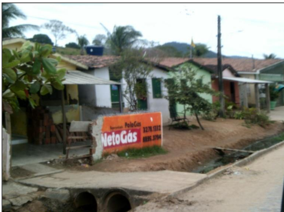
Figura 12 - Esgoto a céu aberto na Rua do Sol
