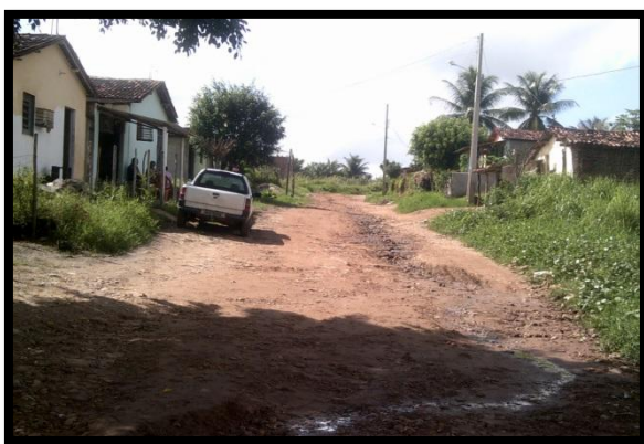
Figura 14 - Ausência de calçamento em uma parte da Rua do Sol
