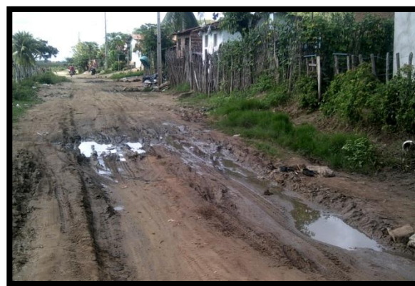
Figura 15 - Rua Chã do Cajá no inverno
