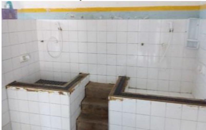
Foto 17 - Banheiro Berçário I e II
