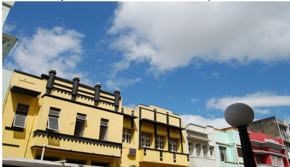
Foto 2 – Conjunto Art Decó no centro de Campina Grande
