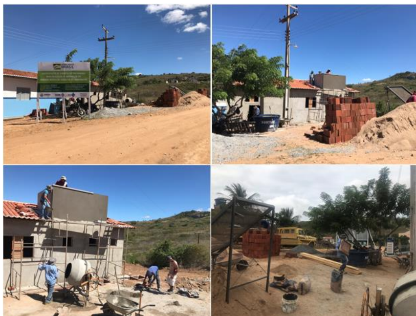
Figura 19 - Situação atual do canteiro de obras
