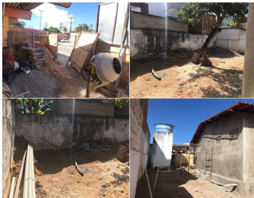
Figura 11 - Situação atual do canteiro de obras
