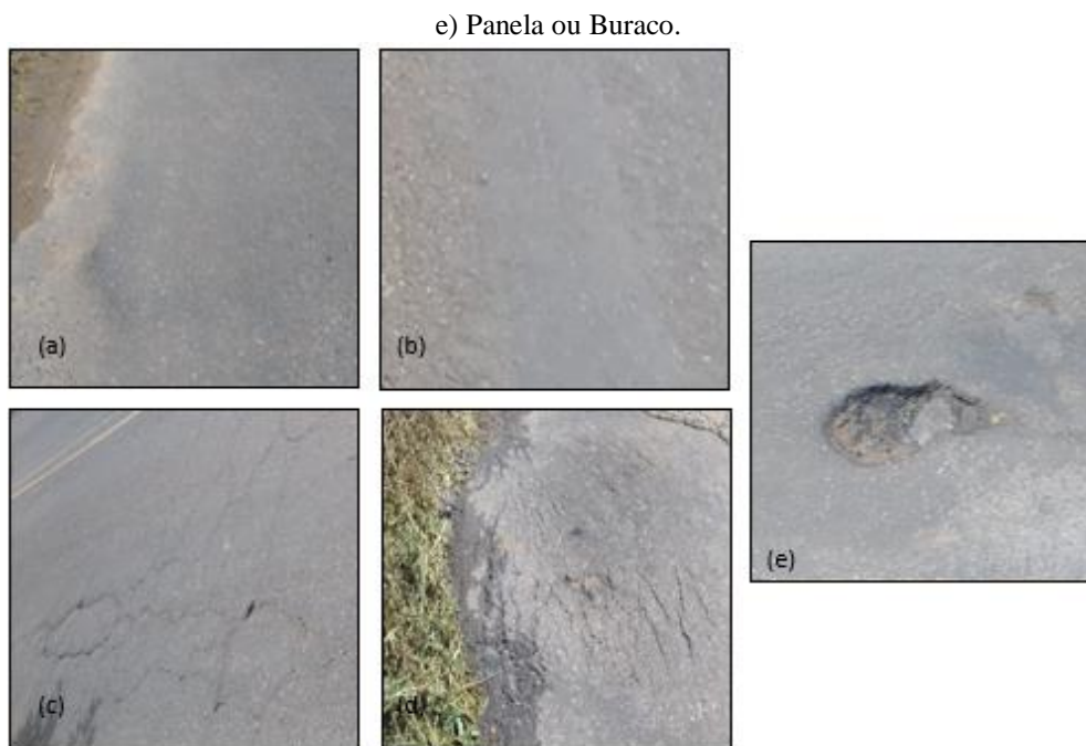
Figura 08: a) Escorregamento, b) Exsudação c) Trinca tipo Bloco d) Afundamento por consolidação Local
