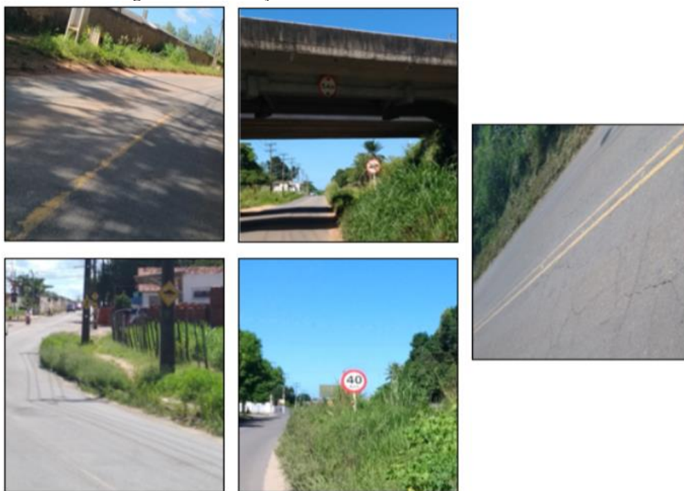
Figura 12: Sinalização Vertical e Horizontal de todo o Trecho
