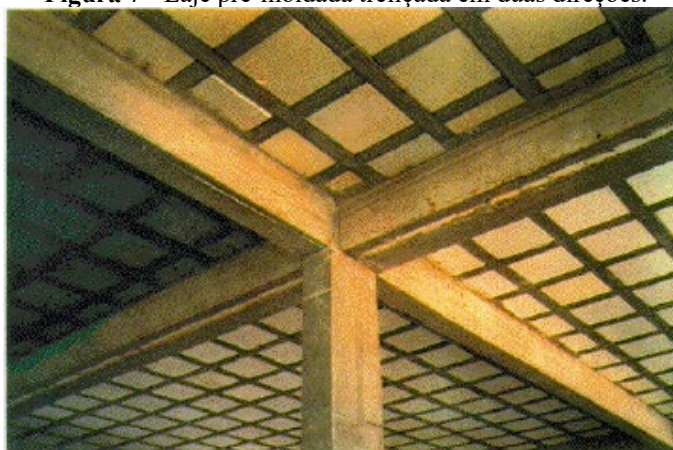
Figura 7 - Laje pré-moldada treliçada em duas direções.
