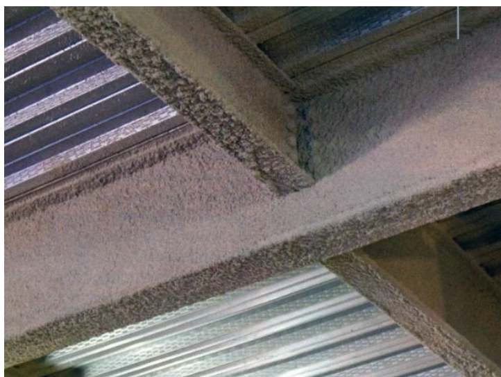
Figura 2.6 – Proteção contra incêndio através de materiais projetados
