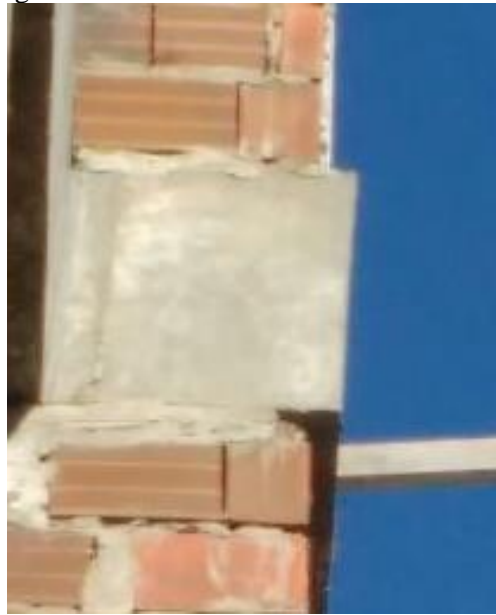
Figura 03 – Prumada de alvenaria da fachada
