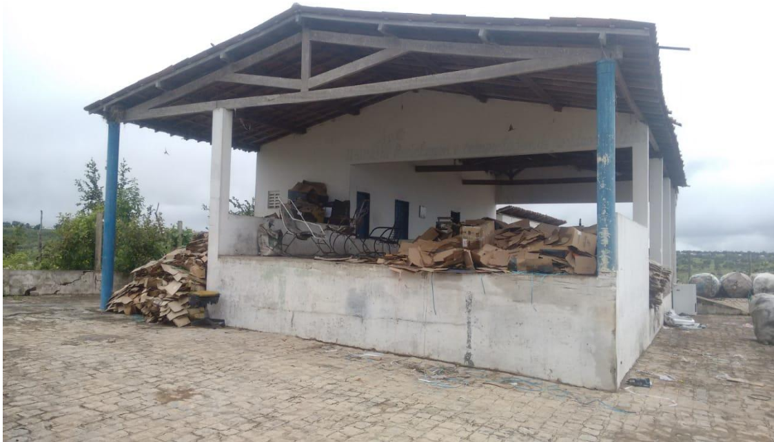
Figura B1 – Fachada da atual usina
