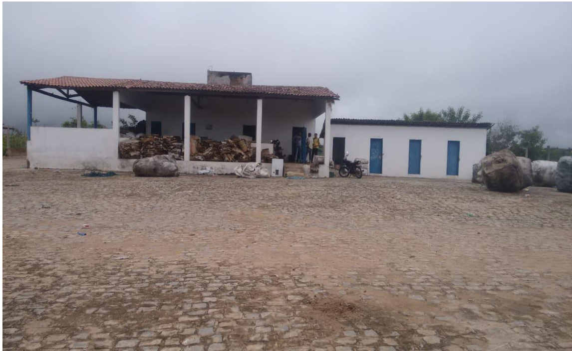
Figura B2 – Usina de triagem em funcionamento
