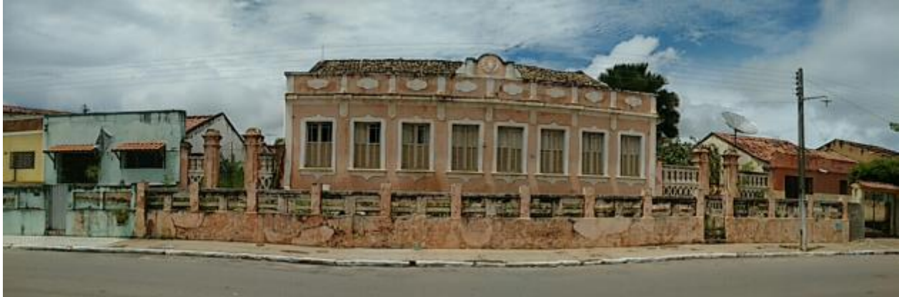
Figura 12 - Vista frontal da Edificação.
