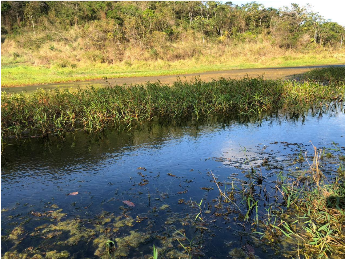
Figura 7 – Assoreamento da barragem
