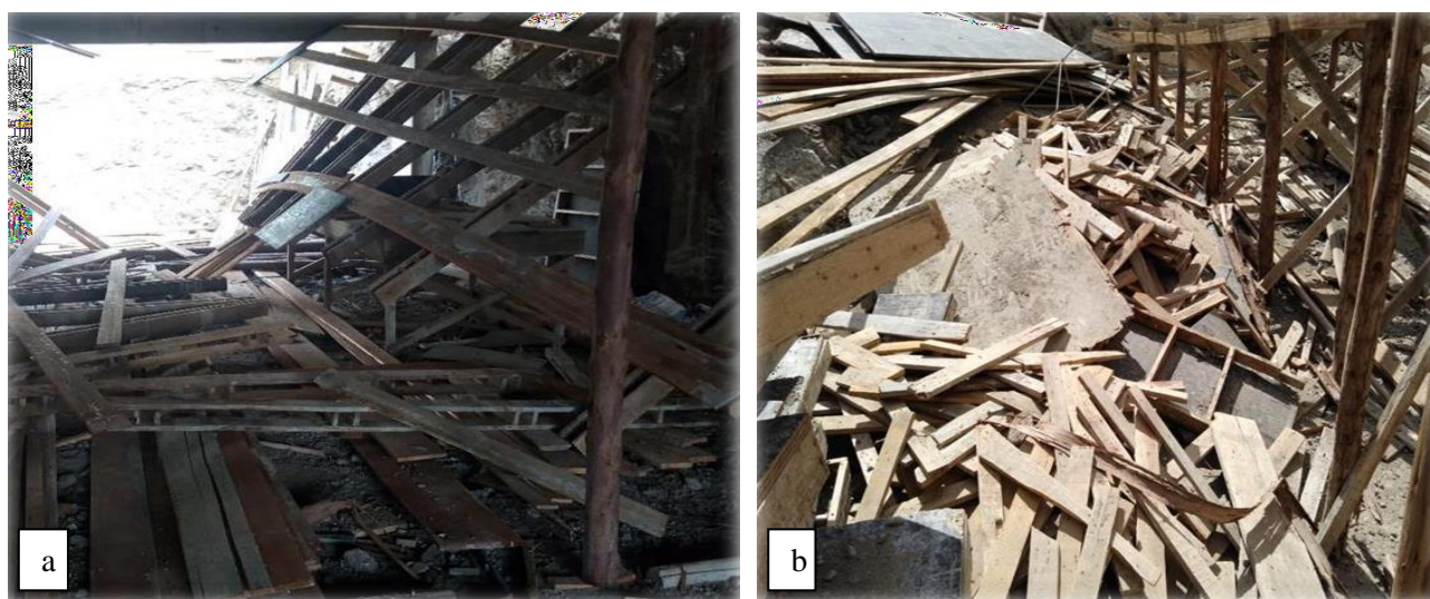
Figura 13: a) problemas com circulação, b) resto de madeira jogado dentro do canteiro.
