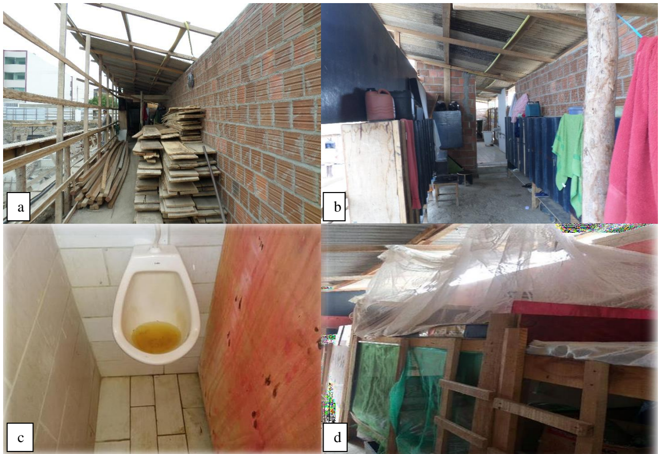
Figura 11: a) acesso com obstrução, b) precariedade no alojamento, c) mas condições de higiene, d) péssimas condições dos dormitórios.
