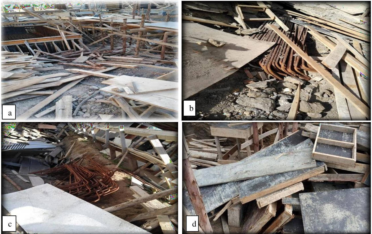
Figura 12: a) entulhos desordenados, b) ferragens misturadas aos entulhos, c) propagação do problema anterior, d) desperdícios de painéis.
